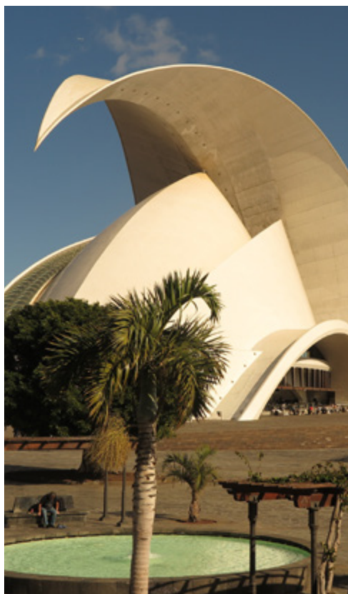
Widok na Auditorio od str. parkingu.
